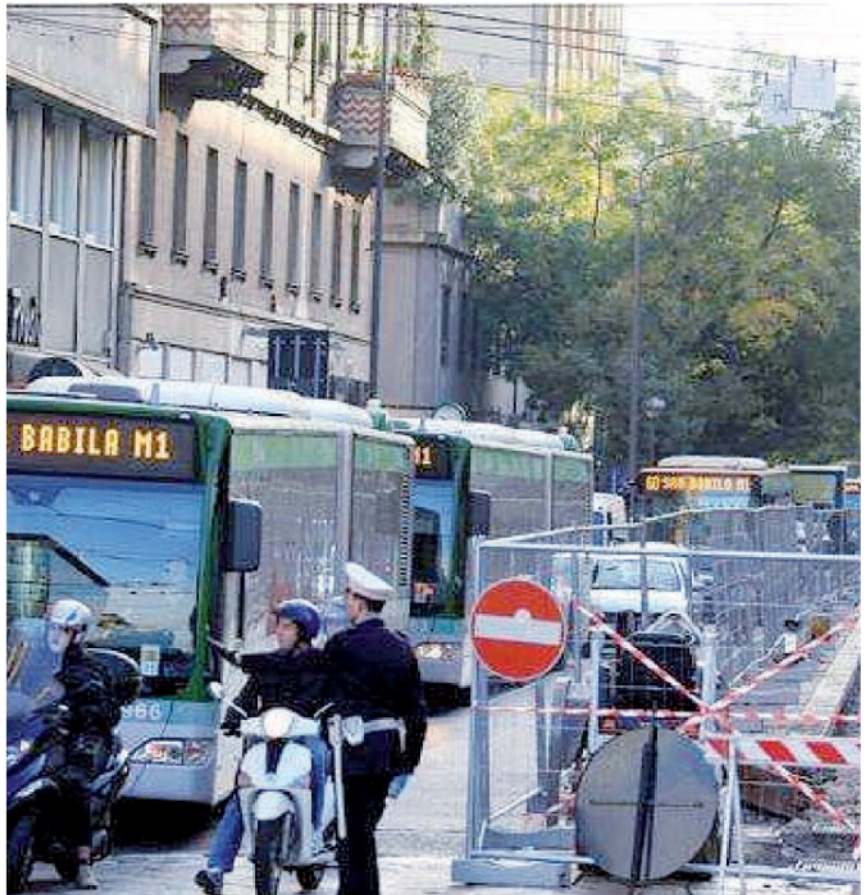
Cantieri in città, estate di lavori
