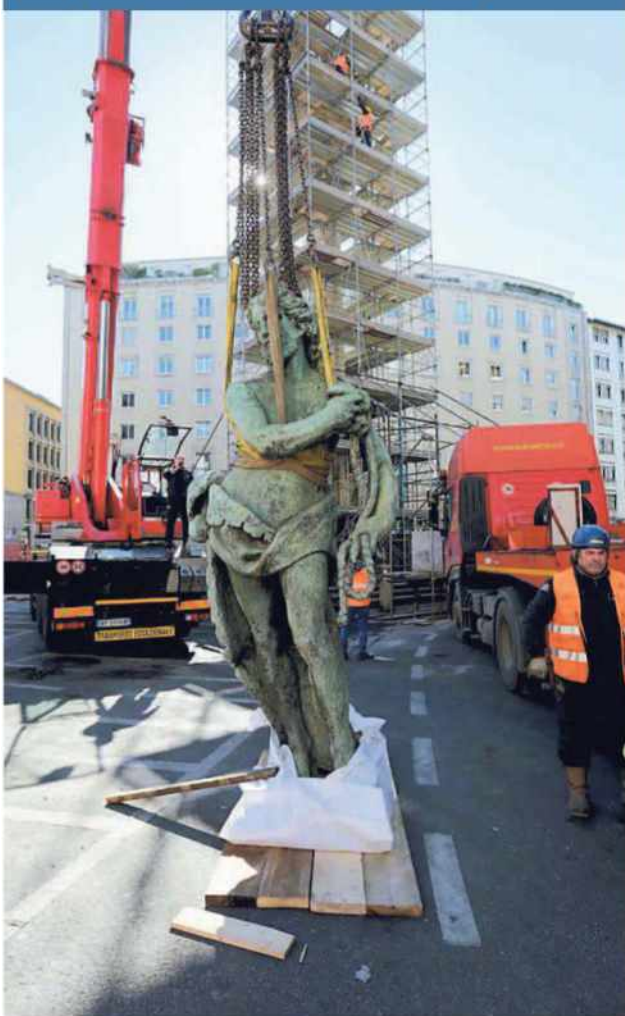
La statua del Cristo Redentore appena smontata dalla sommità della colonna
