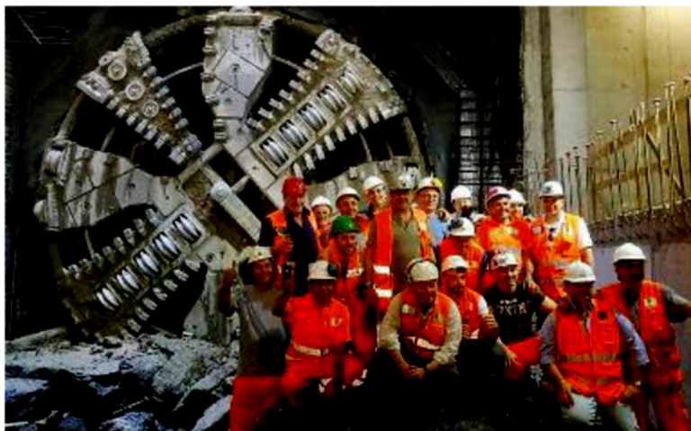
LA SQUADRA Gli operai M4 posano insieme alla talpa per gli scavi
