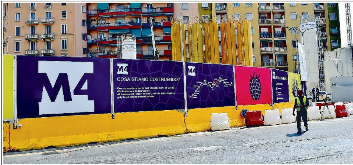
Il cantiere in zona via Foppa della M4: la tratta ovest, fino a San Cristoforo, aprirà solo nel luglio 2023 [Ftg]
