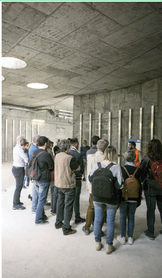
Il cantiere della stazione aperto ai cittadini / Foto gramma
