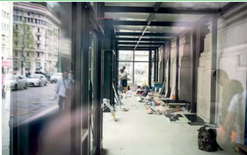
▲ Il Mercato Il cantiere per la cittadella del cibo in Centrale
