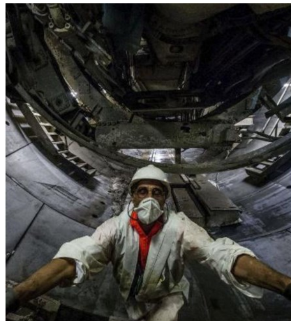
Continuano i lavori nei cantieri della nuova linea blu del metrò che collega San Cristoforo a Linate
