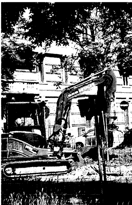
Cantieri di M4
