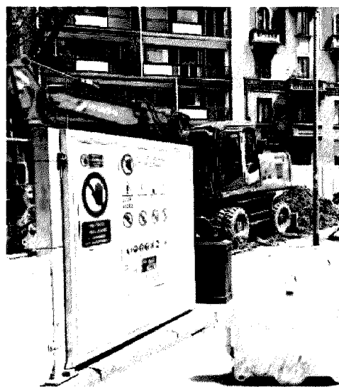
Un cantiere della M4 in via Foppa
