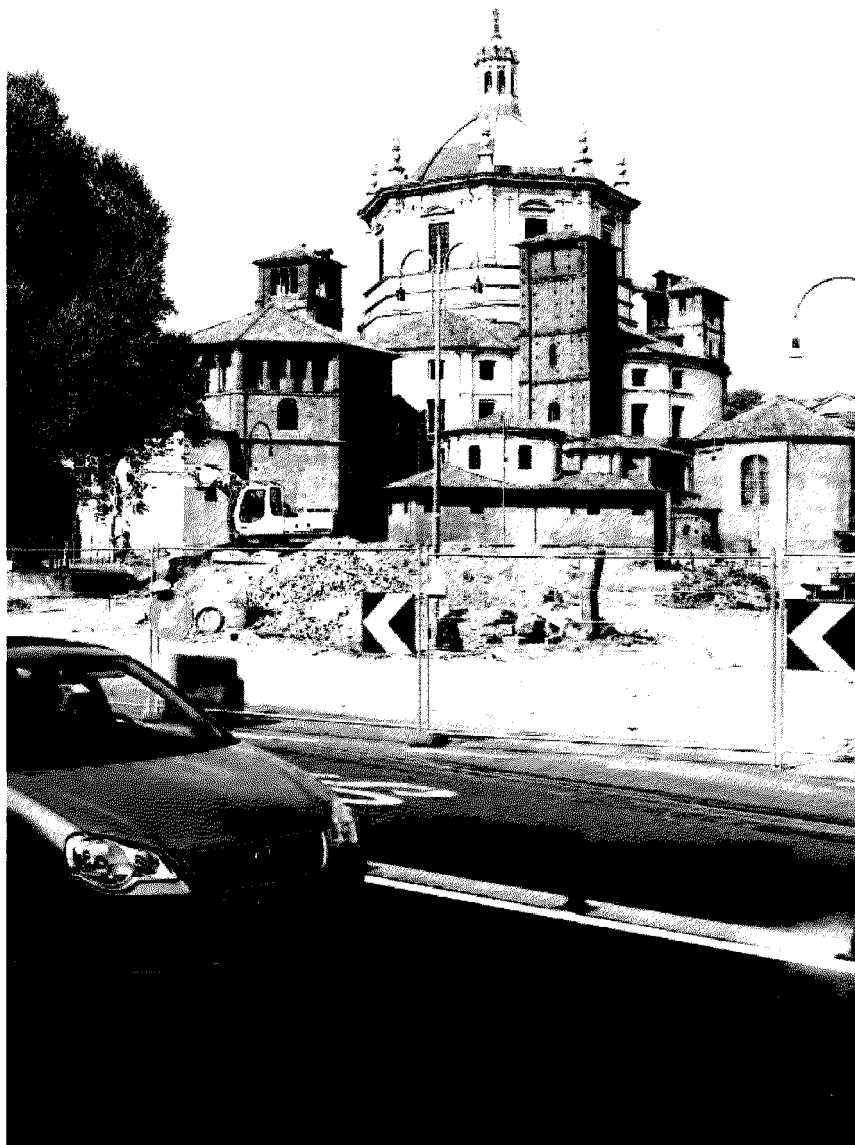
Il cantiere per il metrò 4 in piazza Vetra
